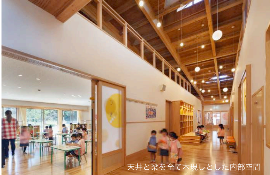
天井と梁を全て木現しとした内部空間
